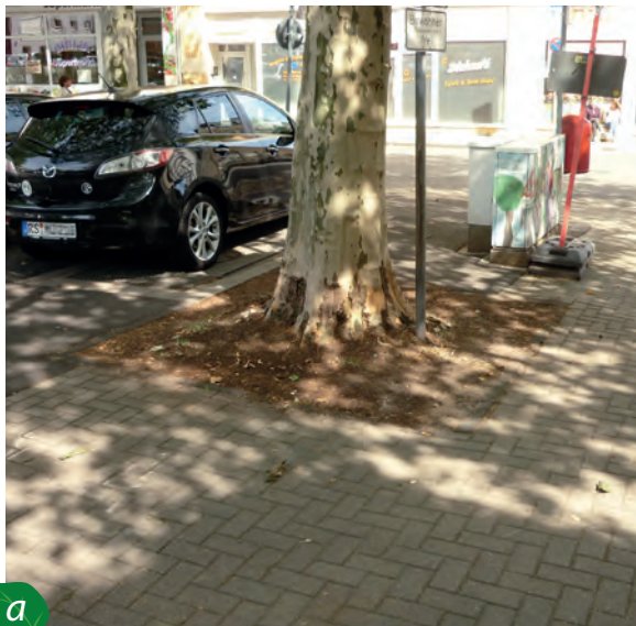
Abbildung 49: Baumstandorte am Neumarkt: a) Die Wiederherstellung der Pflasterfläche um diese Ahornblättrige Platane behebt die zuvor vorhandene Nutzungseinschränkung lediglich temporär, bevor im Laufe der Zeit neue Schäden entstehen, auf die dann immer weniger baumschonend reagiert werden kann. b) Die Winter-Linde ist an diesem Standort vor allem durch die Nutzung des Platzes gekennzeichnet, da sie zerstörerischen Einflüssen von Kraftfahrzeugen vollkommen schutzlos ausgeliefert ist.
