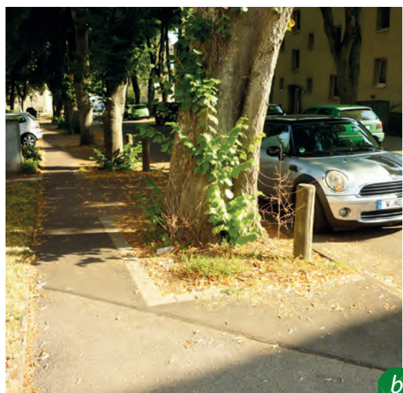
Abbildung 31: Baumstandorte in der Tobienstraße: a) Die Nutzbarkeit des Gehweges ist bei diesem Baum durch den großen Stammumfang und die Wegebelagsanhebungen leicht eingeschränkt. b) Im Einzelfall ist eine erfolgreiche Sanierung unter Baumerhalt, so wie an diesem Standort, auch bei einem alten Exemplar möglich.
