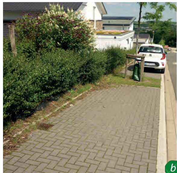
Abbildung 44: Die Anlage von Wurzelgräben in der Siedlung am Winterberg. Die in Abbildung 43 gezeigten Baumstandorte setzen sich im Straßenkörper fort. Den Bäumen stehen so mindestens etwa 15 m 3 dauerhaft gut durchwurzelbares Substrat zur Verfügung, wobei die Wurzelgräben der Reihenspflanzungen untereinander verbunden sind. Ersichtlich wird das an den Einlässen in der Pflasterung, über die eine Tiefenbelüftung stattfindet.
