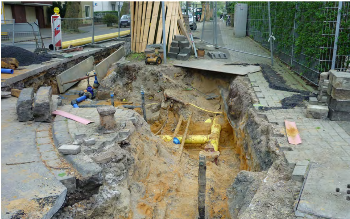
Abbildung 11: Bäume konkurrieren im Straßenbereich insbesondere unter der Erde mit der technischen Infrastruktur um denselben Raum, der knapp bemessen ist und von verschiedenen Parteien beansprucht wird. In aller Regel, so wie in diesem Beispiel zu sehen, wird diese Situation zu Lasten der Bäume mit zum Teil schwerwiegenden Folgen „gelöst“.
