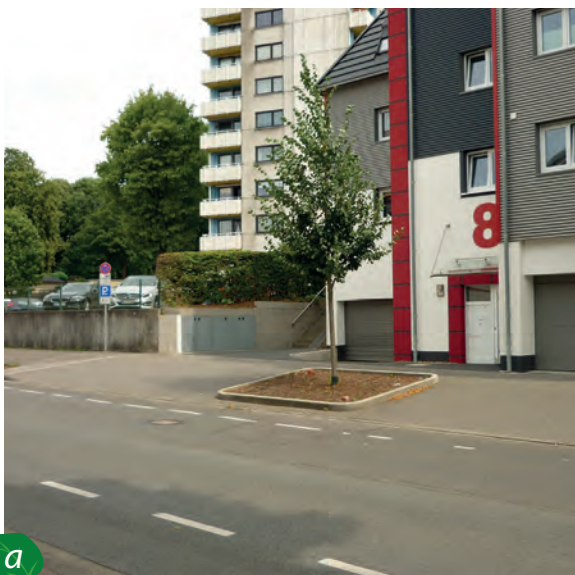
Abbildung 39: Baumstandorte in der Brunnenstraße: a) Eine Neupflanzung in einer großen offenen Baumscheibe im Gehwegbereich. b) Ein älterer Standort mit einer kleinen offenen Baumscheibe innerhalb von Betonpalisaden. Das Hochbord ist nunmehr von Wurzeln ausgefüllt, was zu einem allmählichen Versatz der Einzelelemente führt. Bei der Sanierung solcher Standorte sollten die vorhandenen Palisaden gegen moderne Systeme ersetzt und die Bereiche der offenen Baumscheiben zugleich erweitert werden.
