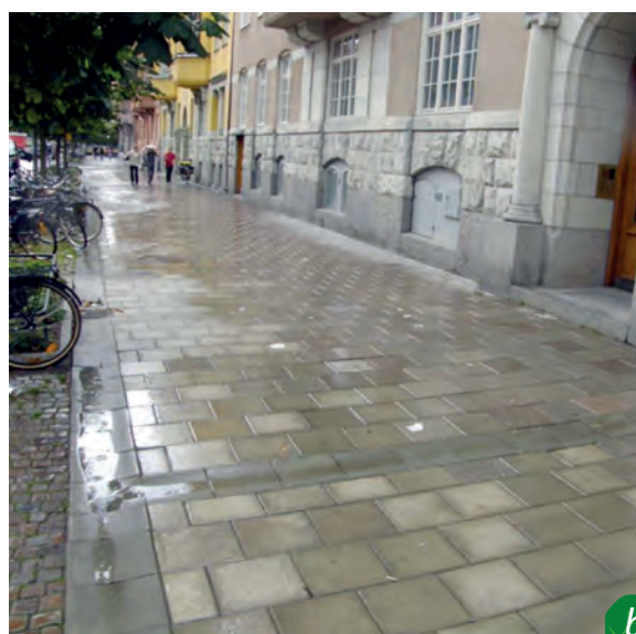
Abbildung 53: Regenwassereinleitung in Baumstandorte am Beispiel der Stadt Stockholm: a) Die Fallrohre haben keinen Anschluss an die Kanalisation und entlassen das Regenwasser auf dem Gehweg, von dem es über den Radweg in die Baumstandorte einfließt. b) Dasselbe Prinzip an anderer Stelle, wo das Dachflächenwasser über den Gehweg in Rinnen zu den Baumstandorten geleitet wird.
