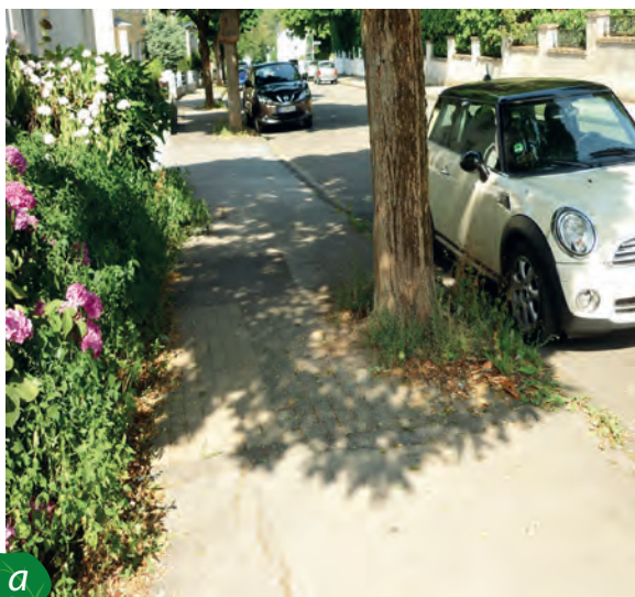
Abbildung 27: Baumpflanzungen im Gehwegbereich der Blücherstraße. Die Bäume sorgen durch Beschattung für Abkühlung und dadurch für ein angenehmes Klima, ihre Lage schmälert die Durchgangsbreiten jedoch wesentlich. a) Schäden durch Wurzeln wurden unter einer teilweisen Entsiegelung saniert. Die offene Baumscheibe wird hierdurch jedoch trittverdichtet. b) Durch die Anhebung der Wegebeläge infolge der Entwicklung oberflächennaher Wurzeln wird die Nutzbarkeit des Baumumfeldes zudem allmählich eingeschränkt.
